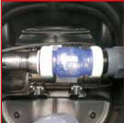
Rückschlagventil RSK und Schmutzwasserpumpe
