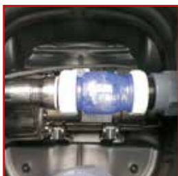
Valvola di non ritorno RSK e pompa per acque reflue
