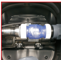
Rückschlagventil RSK und Schmutzwasserpumpe
